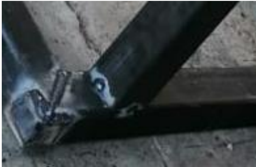
Figura 51. Refuerzos soldados a la maquina
